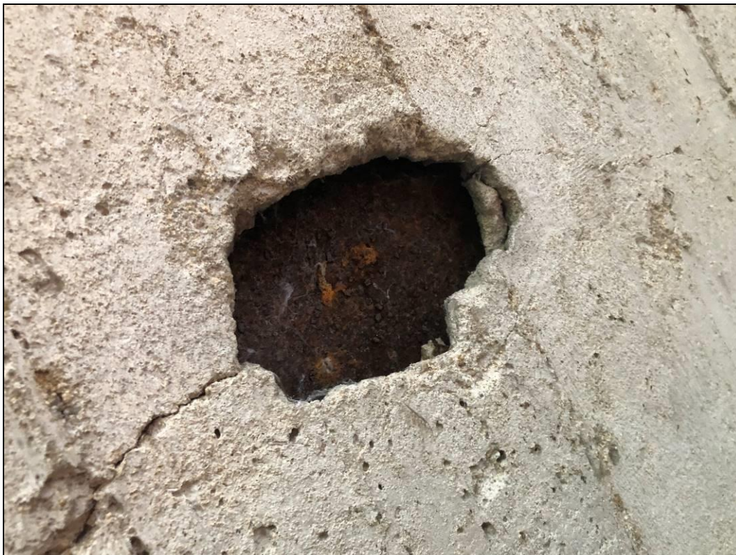
Obr. č. 13 – detailní pohled na opadanou krycí vrstvu betonu ve spodním líci NK. V místě opadu je patrná odhalená spodní pásnice zabetonovaného ocelového nosníku, která je celoplošně postižena korozí.
