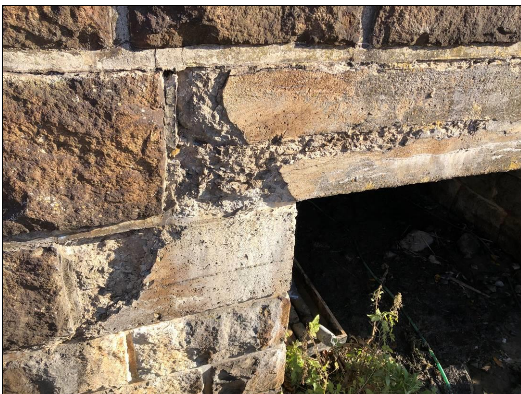
Obr. č. 12 – pohled na levé čelo NK s povrchovou degradací betonu
