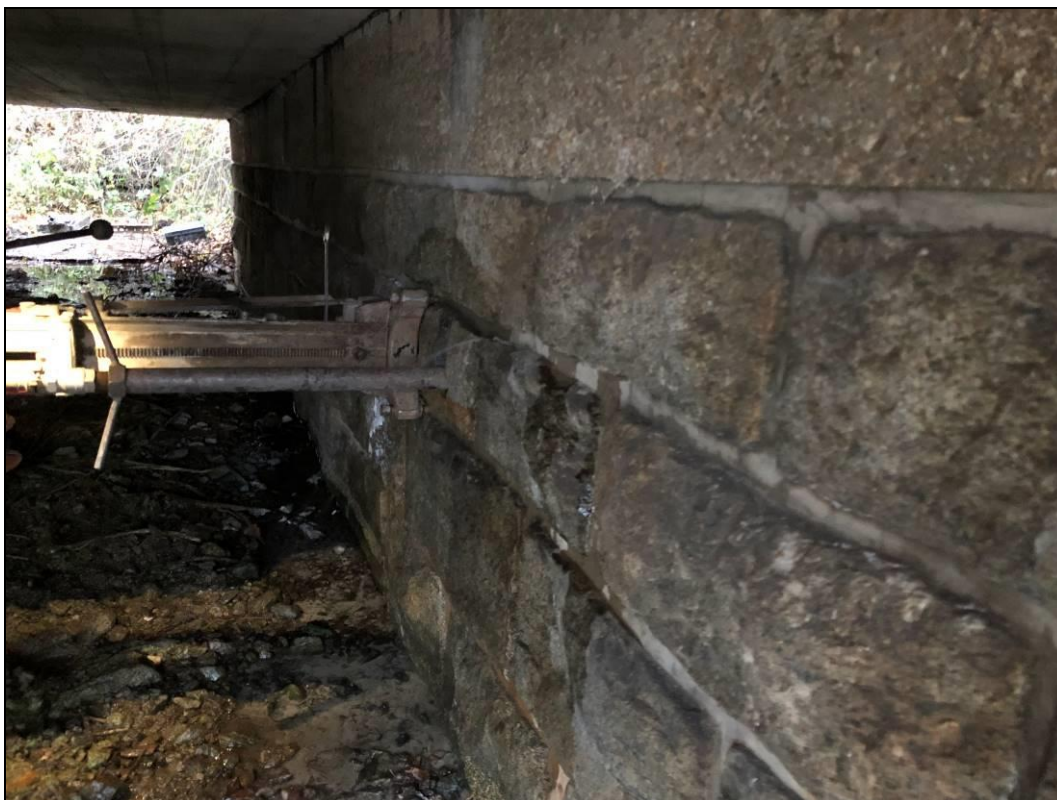
Obr. č. 11 – pohled na spáru, ze které vytéká voda při provádění vodní tlakové zkoušky
